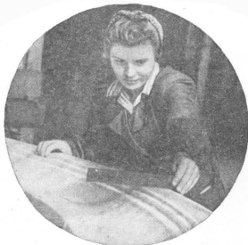
Мастер цеха Рай Сучкова проверяет обработку плоскостей арочных камней.
