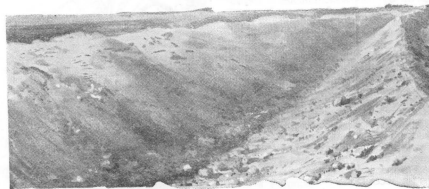
После второго взрыва получилась прекрасная дрена. Наверху — ее профиль в разрезе.
